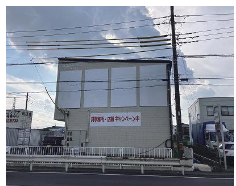
各店舗名称看板(道路側壁面)
