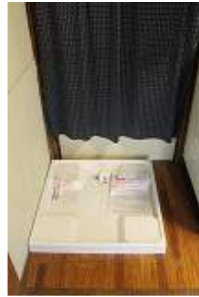
洗濯機置き場
