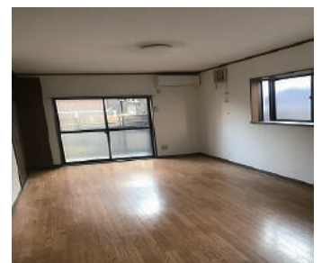
洋室 室内換気扇
